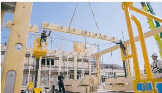
1 柱は岐阜県のライン工業の工場で作られ、現場にトラックで運びました。関東エリアの大工さん方にも、これも木造なのかと建て方について驚かれました。囲柱ラーメン木構造は、柱の数を少なくできる構造なので、まさに鉄骨造の建て方と同様に作業ができます。/2 ドラッグストアの内部です。地震に耐えるラーメン構造の仕口・梁継手と、それに直交配置している鉛直力に耐える張弦梁との構成状況です。/3 ドラッグストアには、12mのスパンが必要となったため、ヒノキの梁材に鋼材を組み合わせた張弦梁を採用しました。斜材にテンションをかけてたわみを抑制し、取付もスムーズに完了できました。/4 フロント側の大きな開口部分に囲柱が並ぶほか、22m x 22mの広い空間の中ほどに立つ囲柱は、3本だけであることがわかります。まとまった一つの空間を分断することがないため、商業施設にはふさわしいと言えます。
